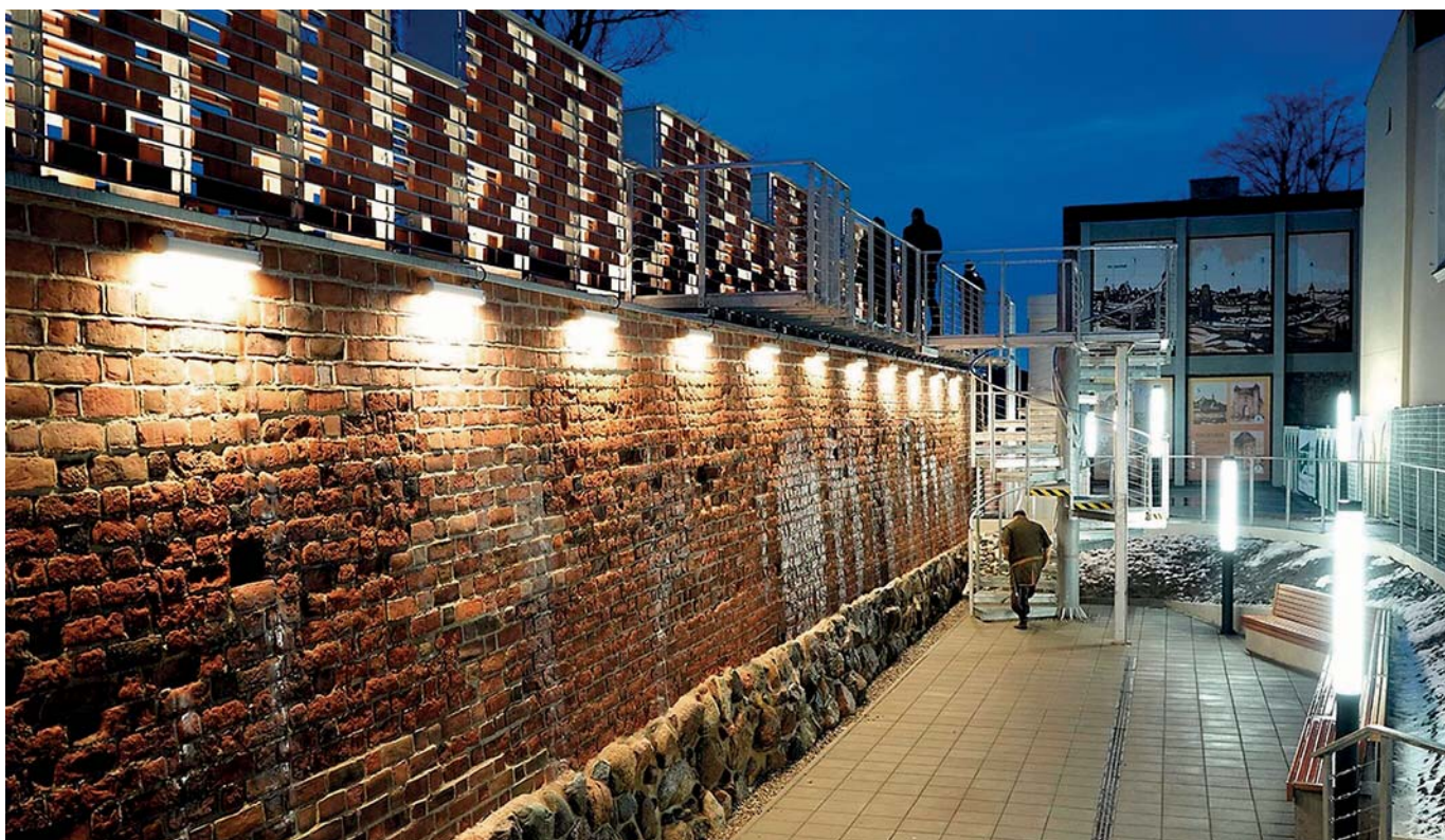
Modernizacja średniowiecznego muru przy ul. Kasztelańskiej w Inowrocławiu autorstwa Archigeum Pracownia Reżyserii Architektury sp. z o.o.
